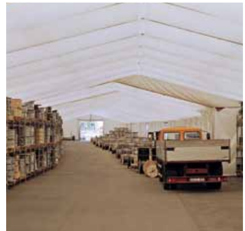
Kabelių ir laidų gamintojo sandėliavimo angaras. [B]
